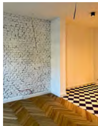
Blick in das sanierte Doppelhaus.
